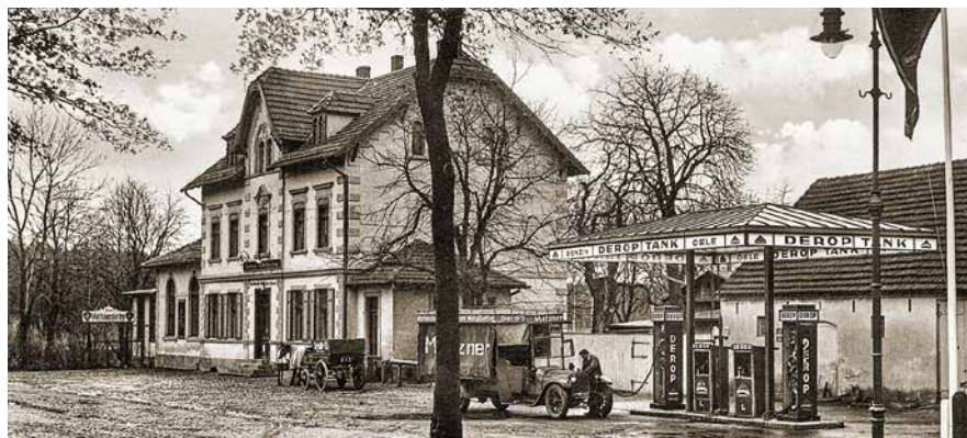
Das Gasthaus um 1925 mit Derop-Groß-Tank- stelle nebenan.
